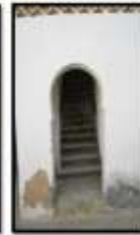
لوحة (١٣) درج سلم بالجهة الشرقية
